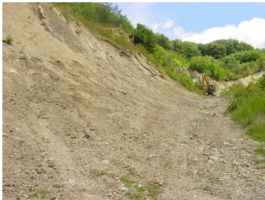
Abb. 3 Pflege Fläche 61a In dieser Fläche wurden zugunsten der geologischen Aufschlüsse alle Gehölze inklusive Wurzeln entfernt (12.06.2009/BST).
