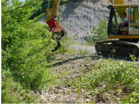
Abb. 1 Pflege Fläche 71b/1 Mit einem speziellen Greifer, der das Bodenmaterial durchfallen lässt, werden die Stöcke von Pappeln und Weiden ausgehoben (10.06.2009/BST).
