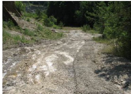
Abb. 1.3 verbesserte Wasserführung Fl. 75a Damit der Bereich vor der Arena bei Niederschlag nicht verschlammt, wurde am Nordrand der Fläche 75a ein kleiner Ablaufgraben erstellt (15.07.2015/SKK).
