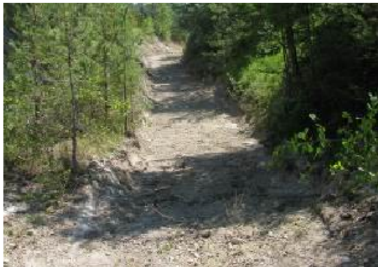
Abb. 1.2 Fläche 75b Mit dem Bagger wurden sämtliche Gehölze ausgerissen und abgeführt (15.07.2015/SKK).
