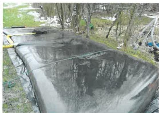
Abb. 3.6 Das Schlammwasser wird in Säcke gepumpt, wo die Feststoffe mithilfe eines Polymers ausgefällt werden (7.12.2017/ SKK)
