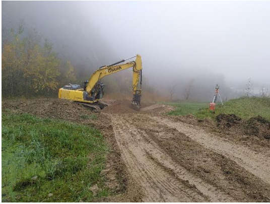
Abb. 1.15 Als Abdichtung wurde erneut kalkstabilisierter Lehm eingebracht (21.10.2024 / SKK).
